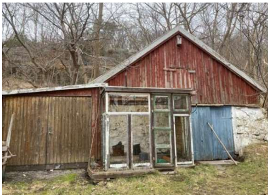
Figur 10 Källarvind med påbyggt garage
